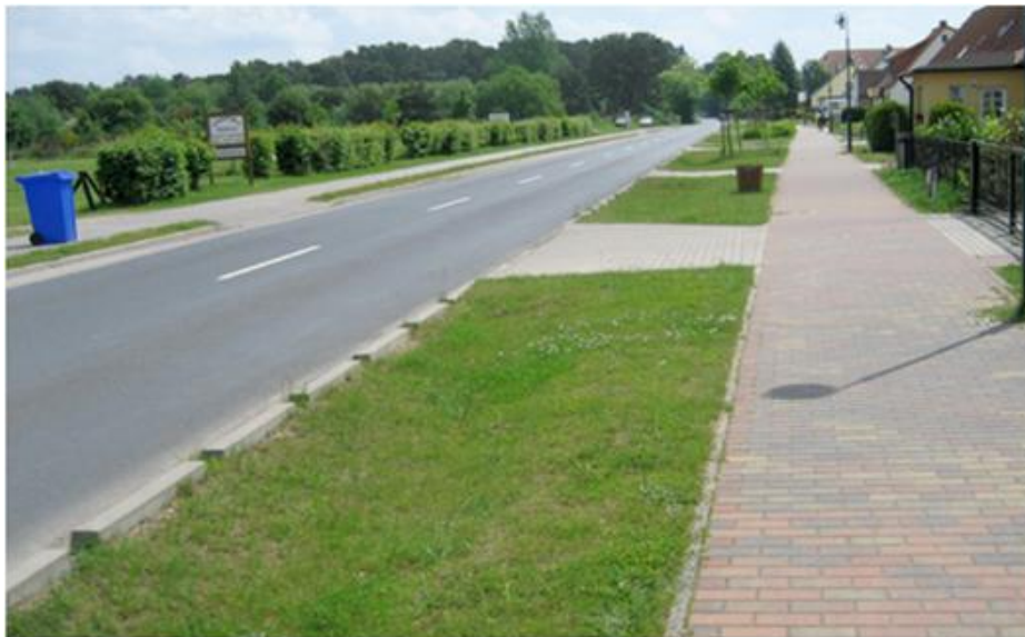
Abbildung 98: Beispiel Mulde im Gehwegbereich
