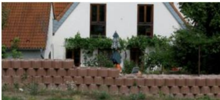
Abbildung 78: Mauer aus Flora-Wall-Steinen zum Schutz vor Außengebietswasser
