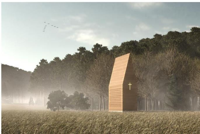
Bei Oberthürheim wird der Plan von Christoph Mäckler umgesetzt werden, der eine 12 m hohe Blockhauskonstruktion vorsieht, die sich an der tradierten Form der einschiffigen Basilika orientiert. Wie vom Stifterehepaar gefordert enthält die Kapelle ein Kreuz und ist komplett aus Holz gearbeitet. Das Innere der Kapelle wird durch viele blaue Fenster erleuchtet.
