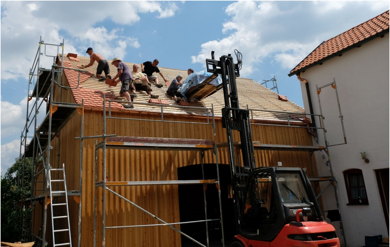
Die Mitglieder des Fischereivereins beim Dachdecken ihres neuen Fischerstadels am Zehentstadel
