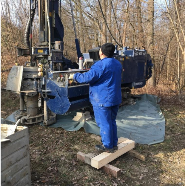
Durchführung einer Kernbohrung im Februar 2018, Quelle: WWA Donauwörth
